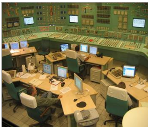
Ábra 5: Paks előregedettségét, elavultságát a szabályzó terem műszerfala mutatja, mely még az SIS1-es biztonsági szintet sem éri el, kézi irányítású és még 20 évig tervezik ilyen állapotban tovább használni.
