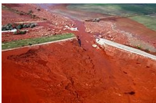
Az Ajkai Timföldgyár zagyatározója 10-es kazettájának átszakadt északnyugati sarka
