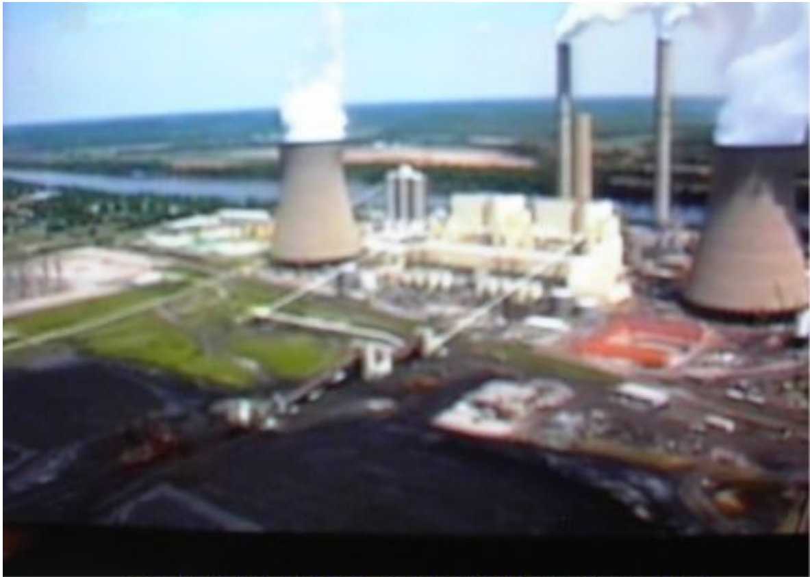
FRANCIAORSZÁGI, RAJNA-VÖLGYI GEOTERMIKUS ERŐMŰ KÜLÖNLEGES ÉPÍTMÉNYEK, GEOTERMIKUS ERŐK National Geographic TV 2008. április 14. (Kód: Geoterm-France-Eromu)
